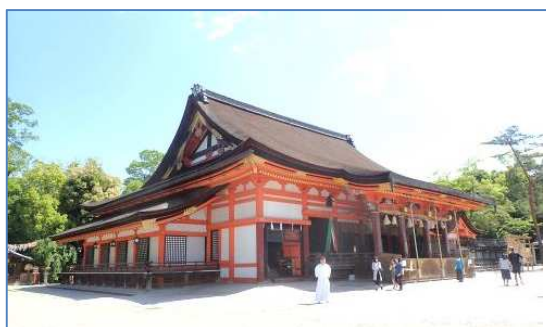
京都八坂神社の本殿…実は仏教建築の御堂であった
